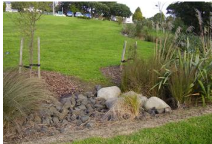
图 4.5-4 公园内植草沟（选用本土植被、挡水堰用于减缓和过滤径流）
