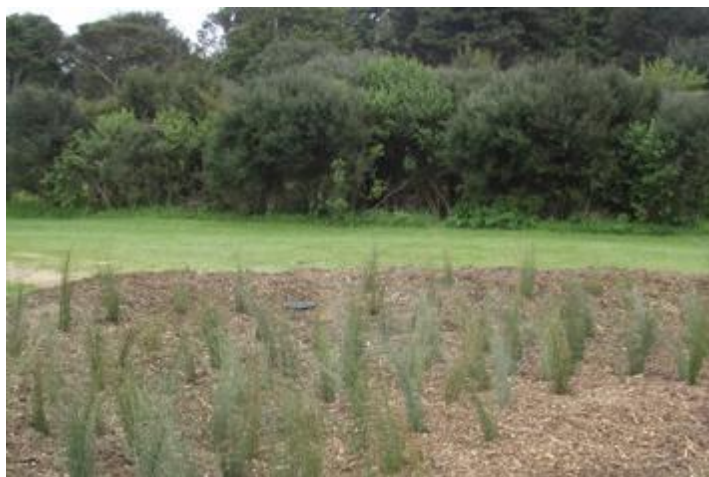
图 4.2-8 完成后的雨水花园，植被种植后做了覆盖层
