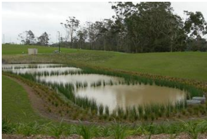
图 4.3-13 重新植草，恢复到施工前状态
