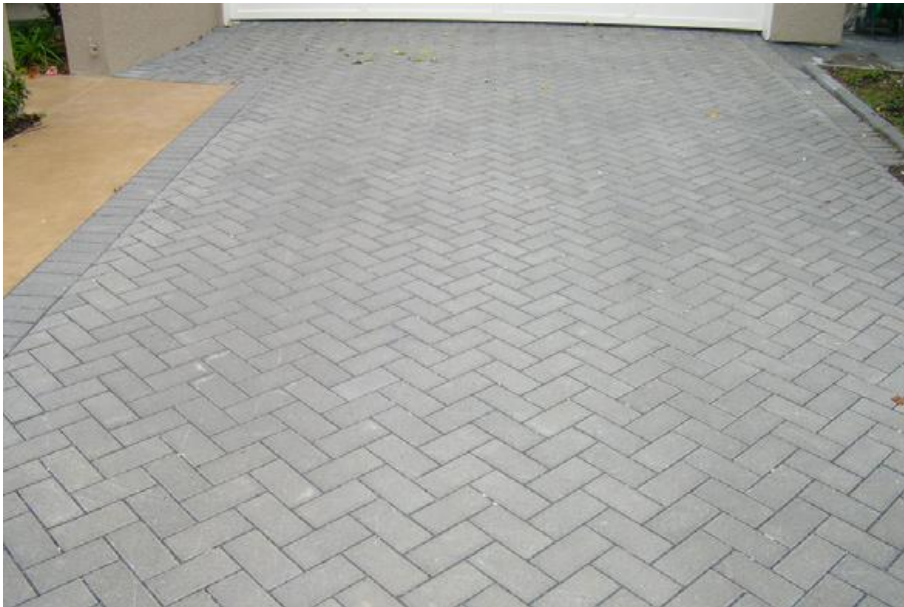
图 4.1-9 建设完成的透水铺装
