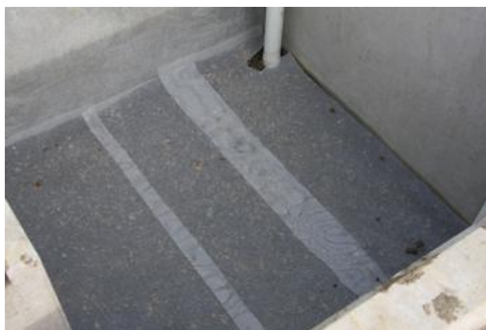
图 4.2-12 已安装的防穿刺层来保护盲管
