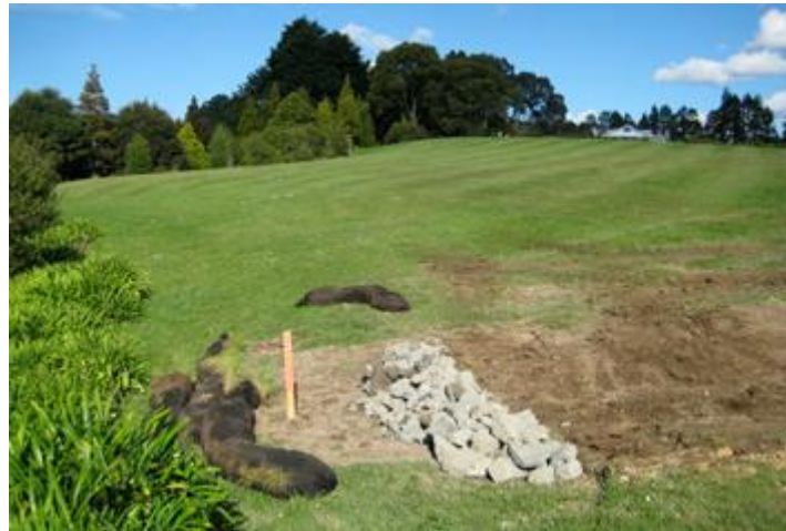
图 4.5-10 施工期间出口处的径流控制措施（也有助于控制沉积物）
