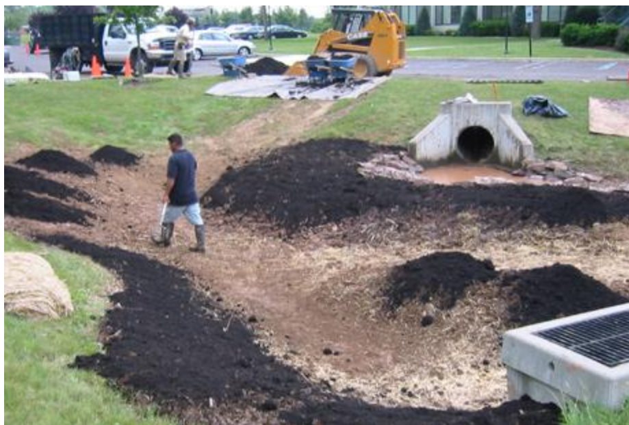
图 4.3-9 形成湿地岸边，添加适宜种植的种植土
