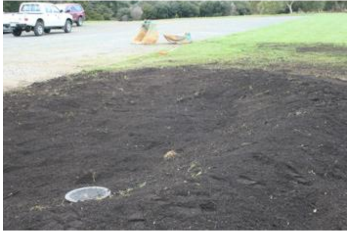
图 4.2-7 土壤轮廓构造出存水区；溢流设施被遮挡
