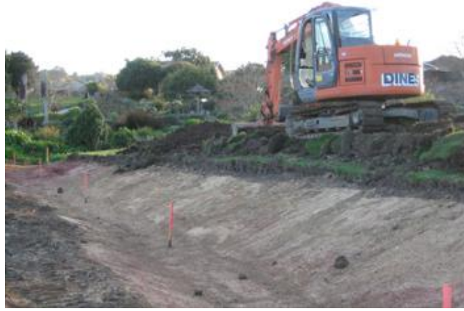
图 4.5-6 开挖形成边坡
