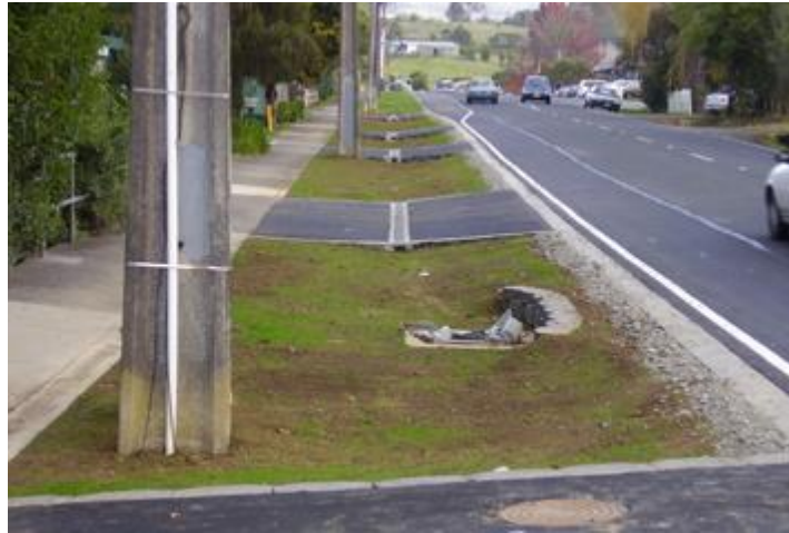
图 4.5-3 路边植草沟（连接植草沟的盲管控制径流流速，并可满足大流量径流从其上方通过）
