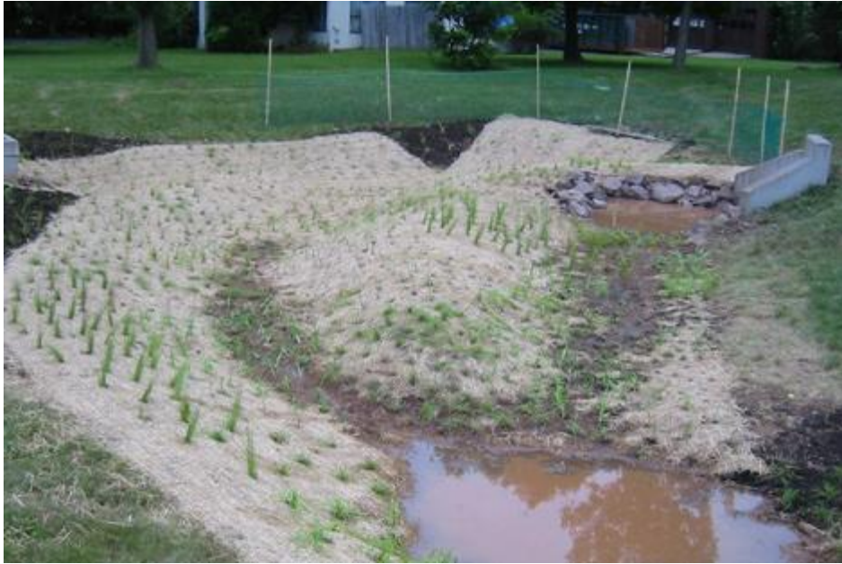
图 4.3-12 种植植被和防土壤侵蚀保护层
