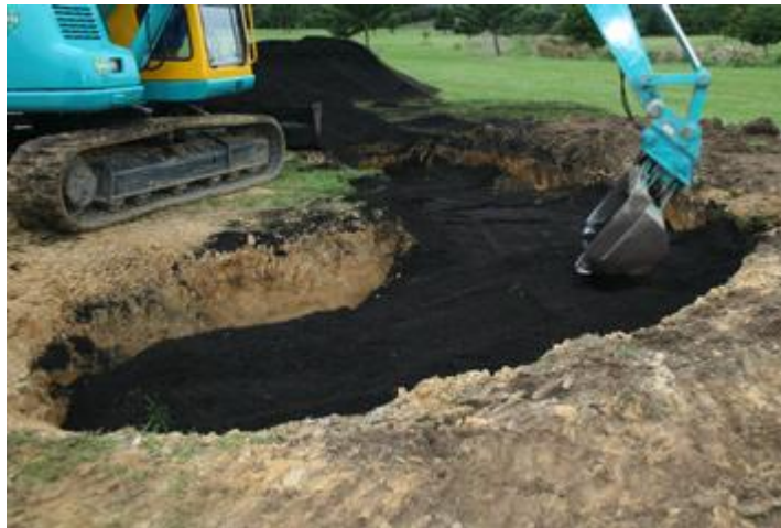
图 4.2-6 土壤混合物的自然压实
