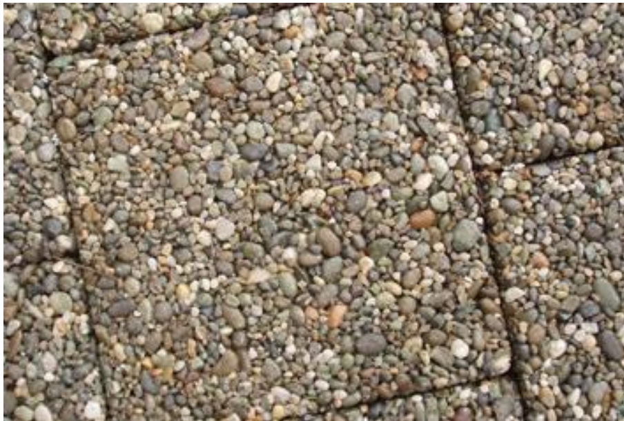
图 4.1-2 多孔透水铺装模块
