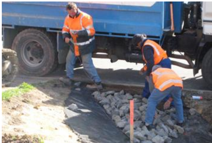
图 4.5-7 植草沟入口处的防侵蚀保护措施
