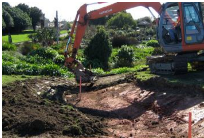
图 4.5-8 准备种植所需的表层土（至少 100mm）
