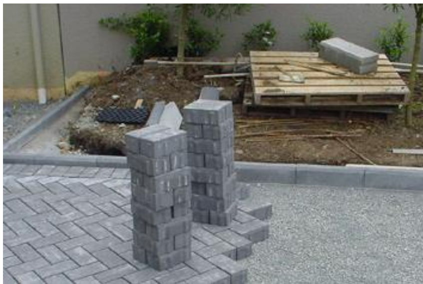
图 4.1-8 透水铺装的铺设
